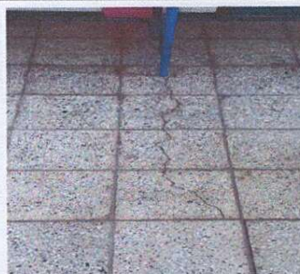
Foto 6: Sustrucion de piso de granito.
