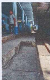
Foto1: Reparación de gradas y sustitución de losa en corredor y frente de cocina
