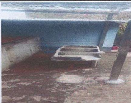
Foto 3: Reparacion de losa de patio de concreto
