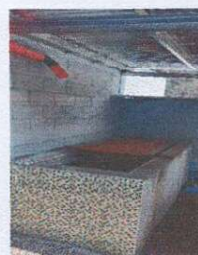
Foto 4: Sustrucion de tapdera de tanque
