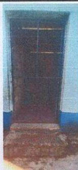
Foto 3: Sustitución de puerta en cocina
